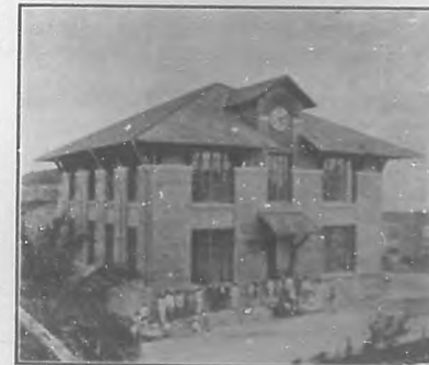
Escuela Pública "Aurelia Castillo", en Nuevitas (Camagüey).
